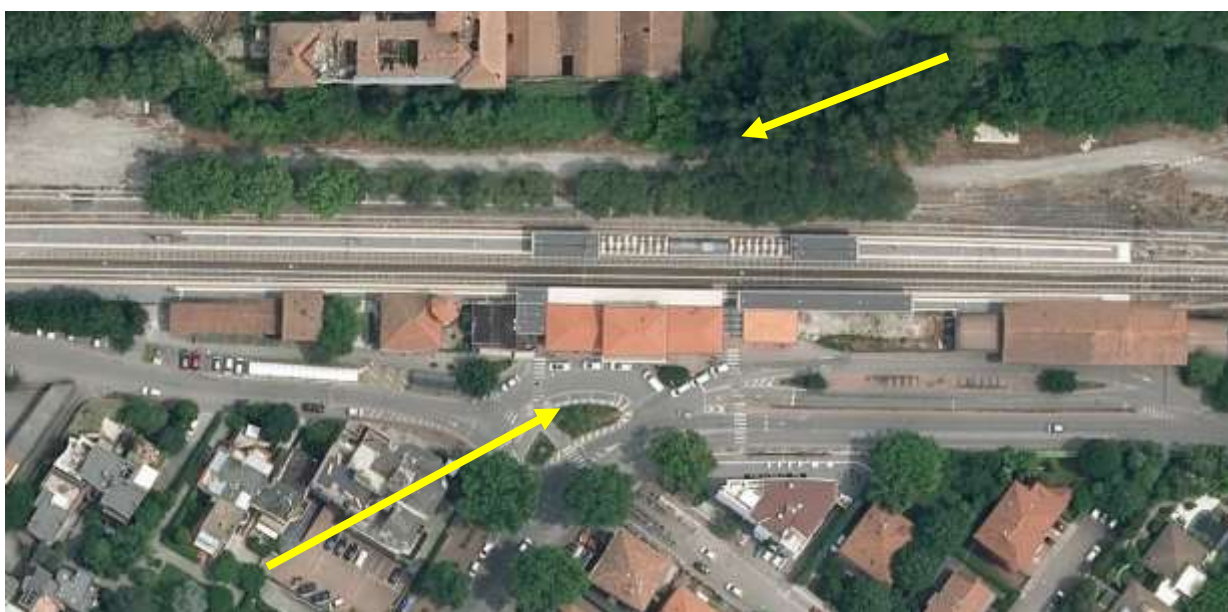
Vista aerea degli interventi
