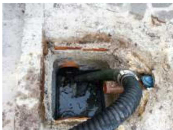
Foto 4 - Espurgo e lavaggio pozzetto
