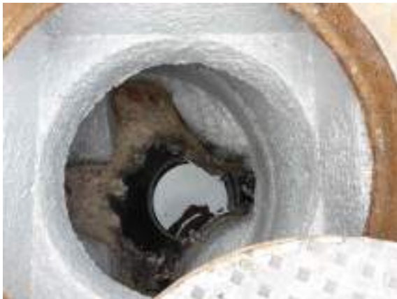
Foto 7 - Ripristino pareti e fondo con resina epossidica
