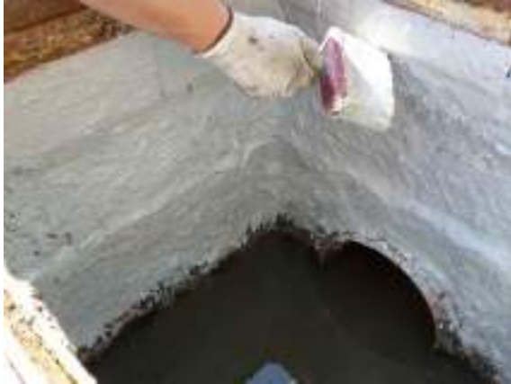
Foto 5 - Ripristino pareti e fondo con malta cementizia
