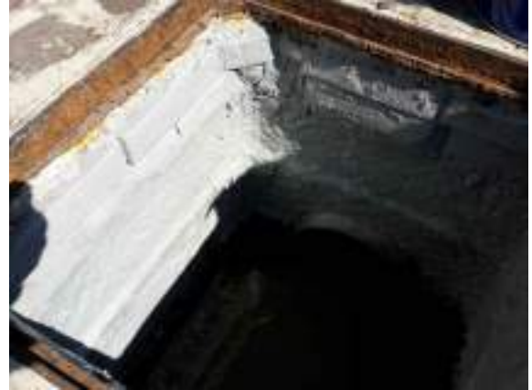
Foto 6 - Ripristino pareti e fondo con malta cementizia
