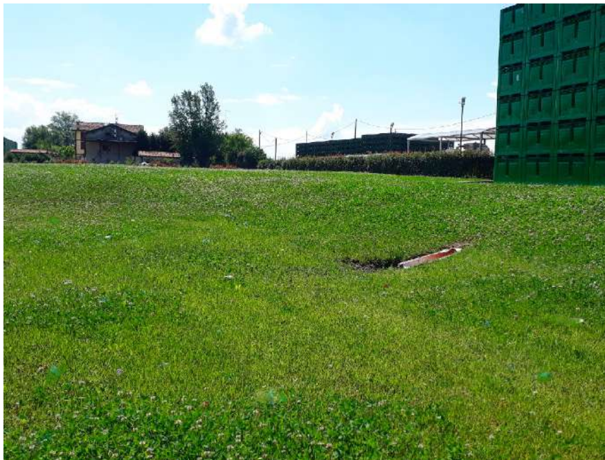
Aspetto di invaso di laminazione recentemente costruito (ditta Monterè - 2022 )
