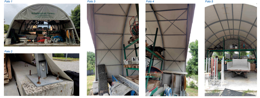
FOTO TENSOSTRUTTURA 5 STRUTTURA METALLICA ANCORATA CON TIRANTI AD UN CORDOLO IN C.A. COPERTURA IN PVC OPACO COLORE BEIGE.
