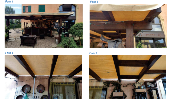
FOTO TETTOIA 6 STRUTTURA IN LEGNO CON COPERTURA AD UNA FALDA IN PVC OPACO COLORE BEIGE.
