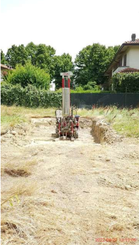
Foto3: particolare esecuzione Cpt 11 eseguita al interno di piazzola per asporto riporto
