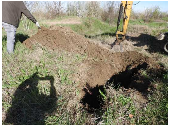
Foto n.38 – terreno sondaggio a -2.10 m
