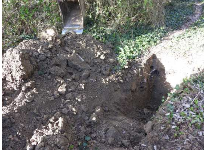
Foto n.20 – terreno sondaggio a 1.45 m
