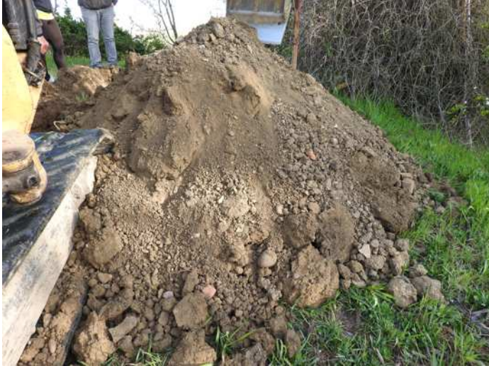
Foto n.19 – terreno sondaggio a -2.35 m
