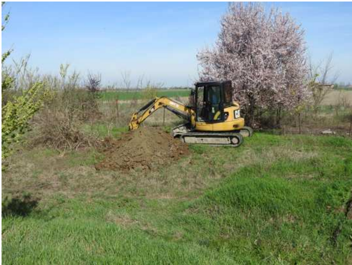
Foto n.31 – Panoramica sondaggio con escavatore.
