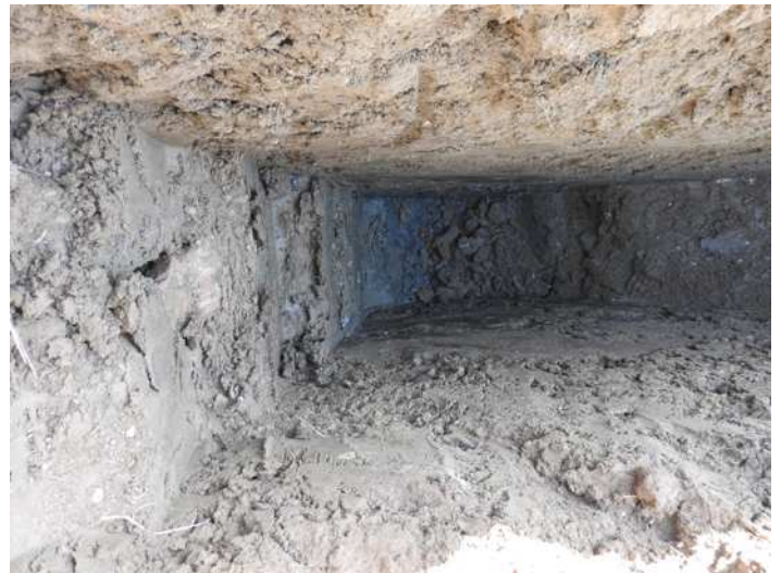
Foto n.40 – Foto sondaggio a -2.50 m
