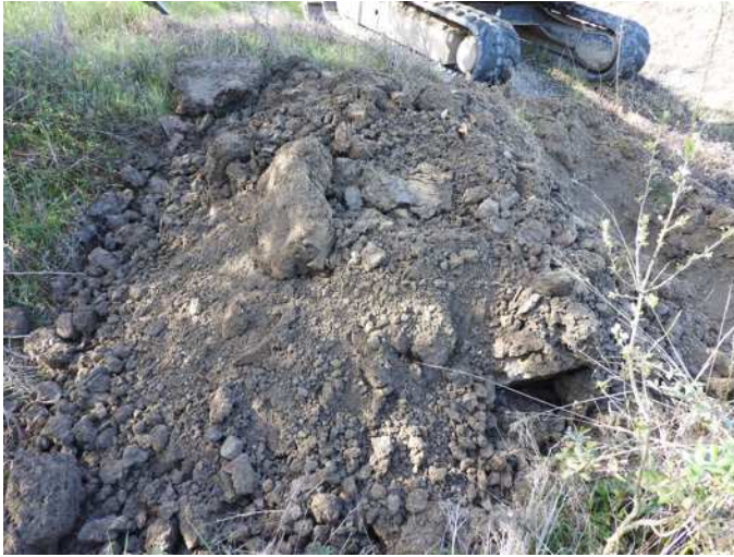
Foto n.23 – terreno sondaggio a -2.35 m
