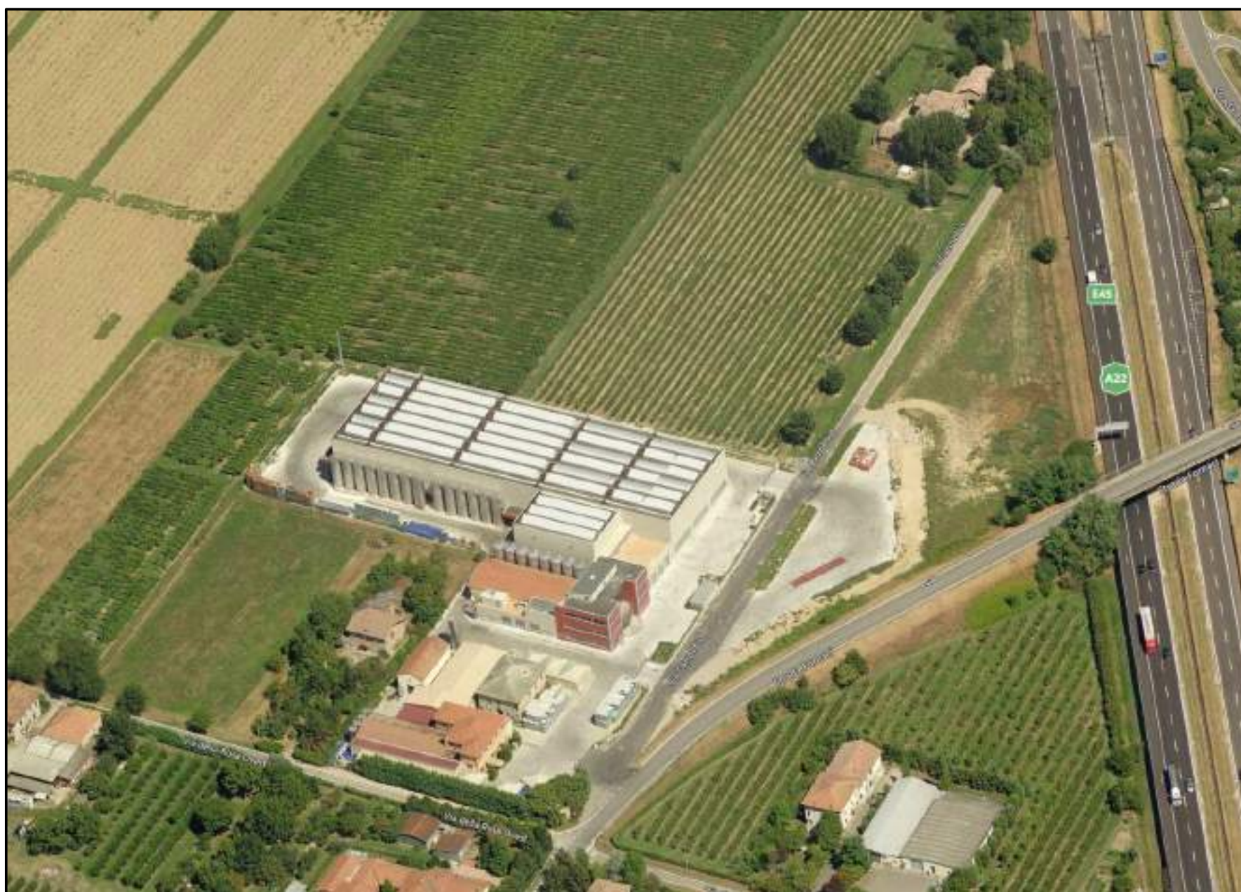
Figura 3 – Foto aerea di dettaglio dello stabilimento A.I.M.O.
