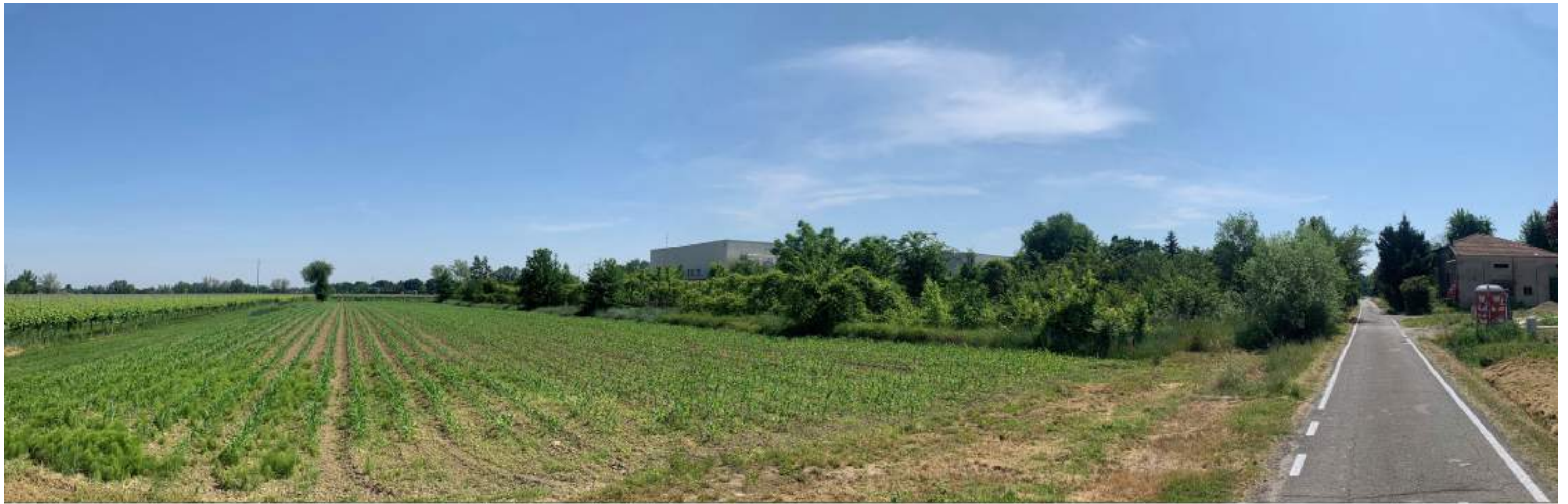
2 - Vista Panoramica dello stabilimento da via della Rosa Ovest
