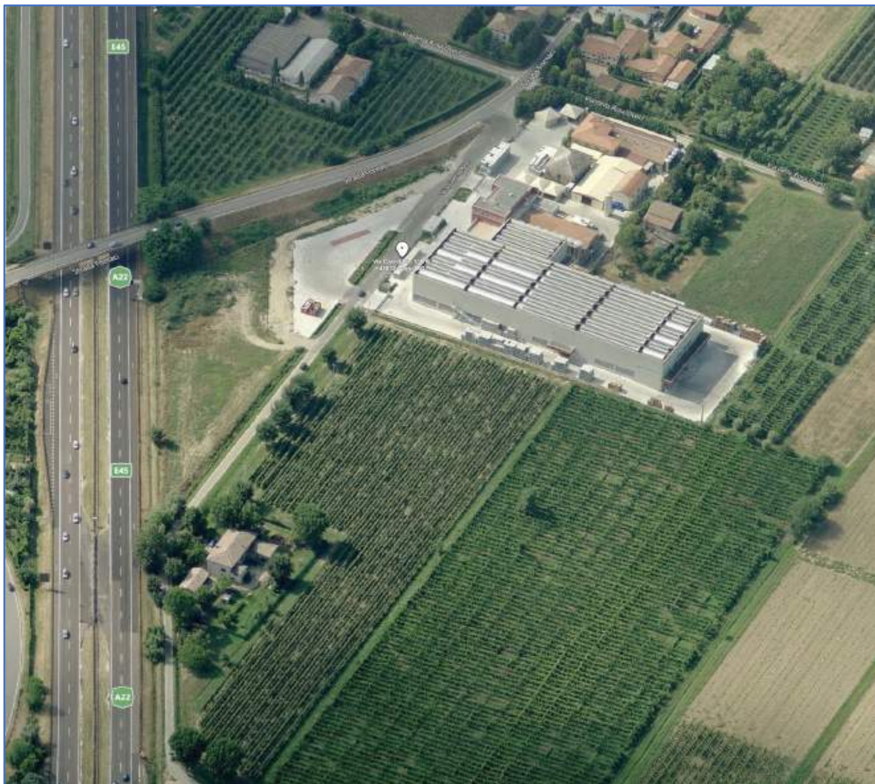
Figura 8 – Foto aerea dello stabilimento A.I.M.O. con accesso dalla via Carrobbio
