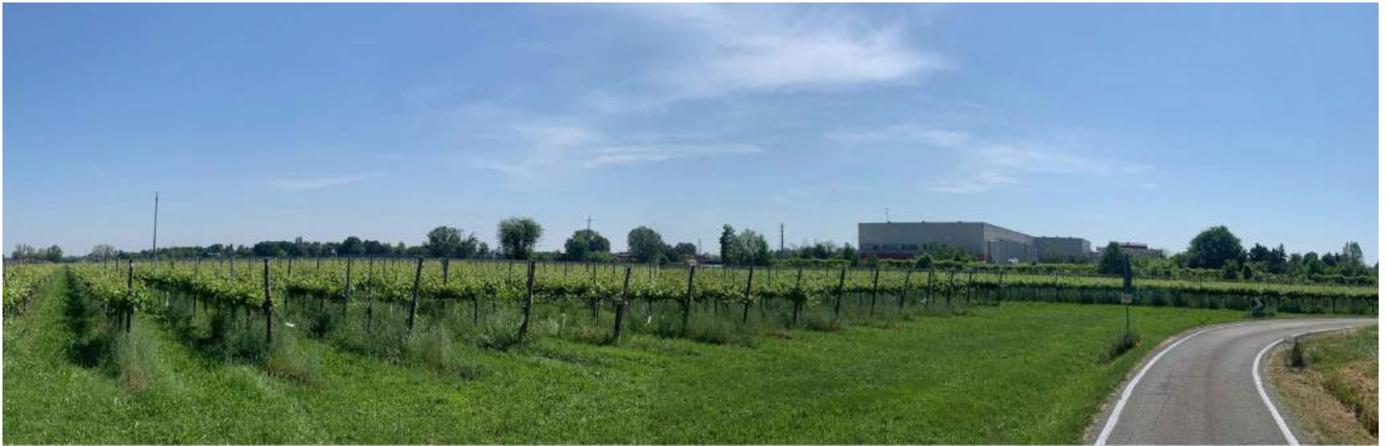
1 - Vista Panoramica dello stabilimento da via della Rosa Ovest
