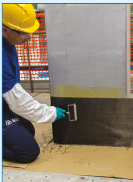
Applicazione del tessuto MapeWrap C UNI-AX impregnato con MapeWrap 31
