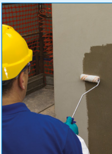
Applicazione di MapeWrap Primer 1
