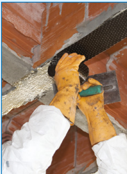
Rinforzo a flessione travetti solaio latero-cemento con MapeWrap C UNI-AX System
