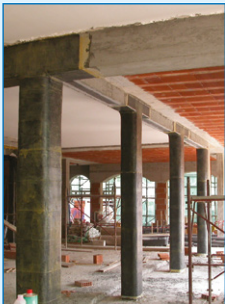
Rinforzo nodi e pilastri con MapeWrap C UNI-AX System
