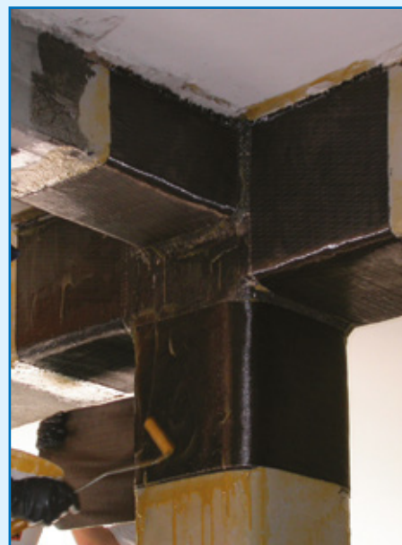
Confinamento nodo trave-pilastro con MapeWrap C UNI-AX System
