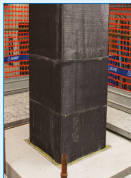
Pilastro confinato con MapeWrap C UNI-AX System
