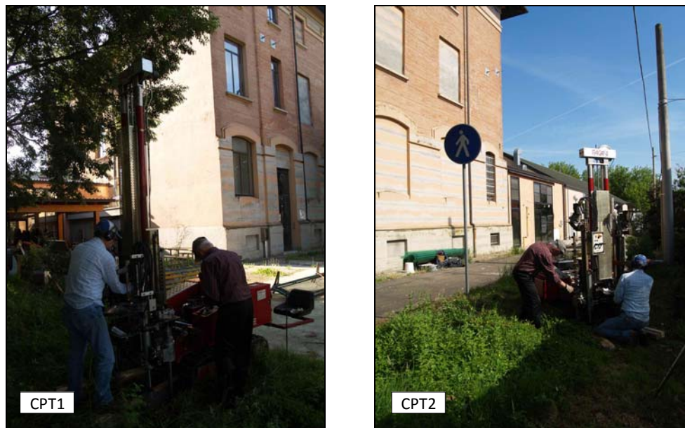
Figura 14 – Esecuzione prove penetrometriche
