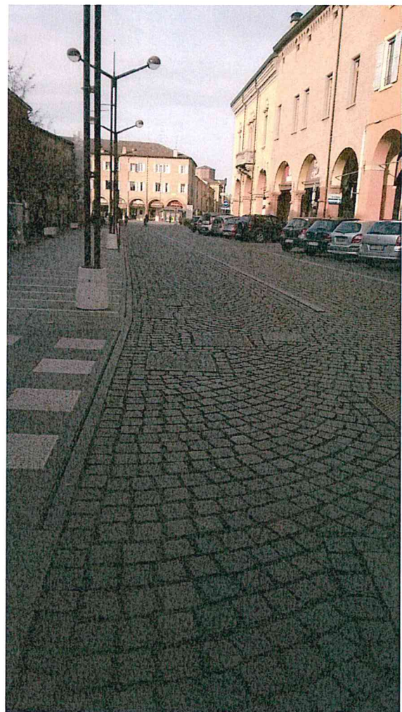
C.so Cabassi – particolare della ciclopedonale
