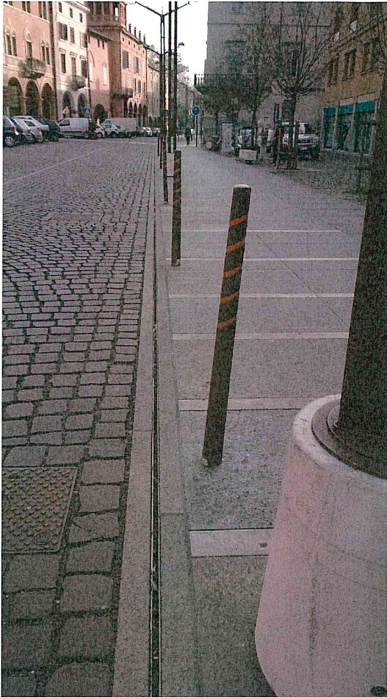
C.so Cabassi – particolare della ciclopedonale e caditoia
