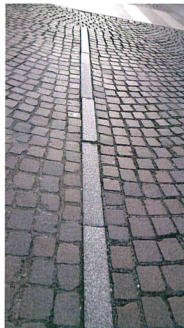
C.so Fanti – cordolo in granito di montorfano
