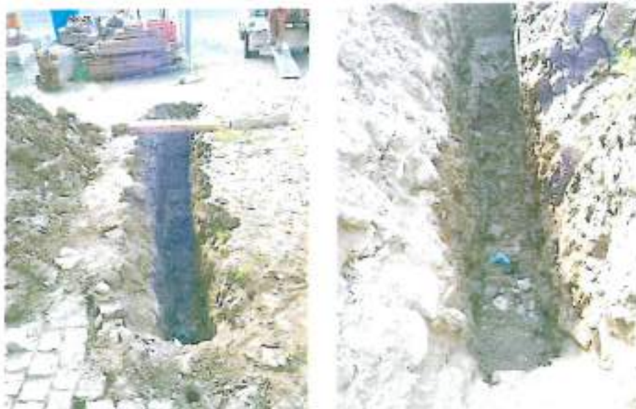
Foto1-2: saggio eseguito presso spigolo NW Torrione per consentire ancoraggio del penetrometro, che è risultato non possibile, per la presenza di rottame antropico di media dimensione frammito a terreno anche a profondità maggiori rispetto al fondo scavo ( \approx -1,8/-2 \text{ m} ); foto a sx panoramica ubicazione saggio foto a dx particolare, si nota a fondo scavo l'assenza di venute idriche e terreno frammito a scarti di laterizio o/o materiali antropici, presenti anche più in profondità (sino a -2,5/-2,7 \text{ m} ), che hanno impedito l'esecuzione della prova CPT. Per l'esecuzione della CPT è risultato quindi indispensabile spostare l'ubicazione più a nord, come indicato in Tav. 4.
