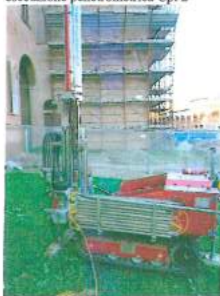
esecuzione penetrometrica Cpt 2
